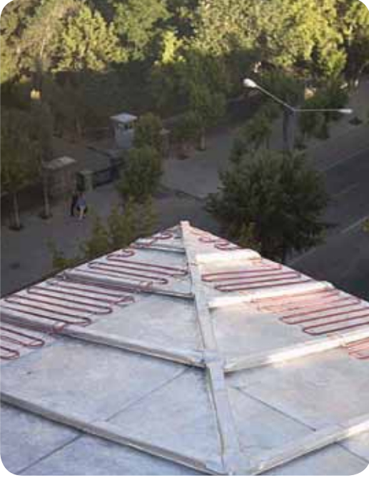
Alkazan Apartmanı - Kar-Buz Birikimini Engelleme Sistemi ERZURUM
