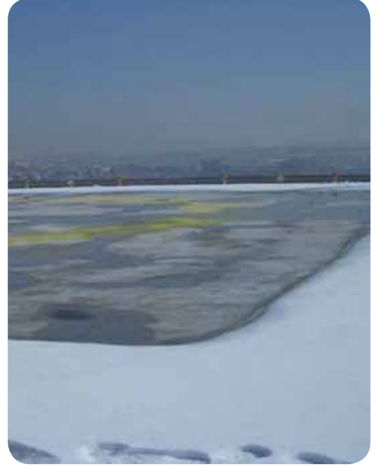
Büyükşehir Belediyesi Binası Helikopter Pisti Kar-Buz Birikimini Engelleme Sistemi ANKARA
